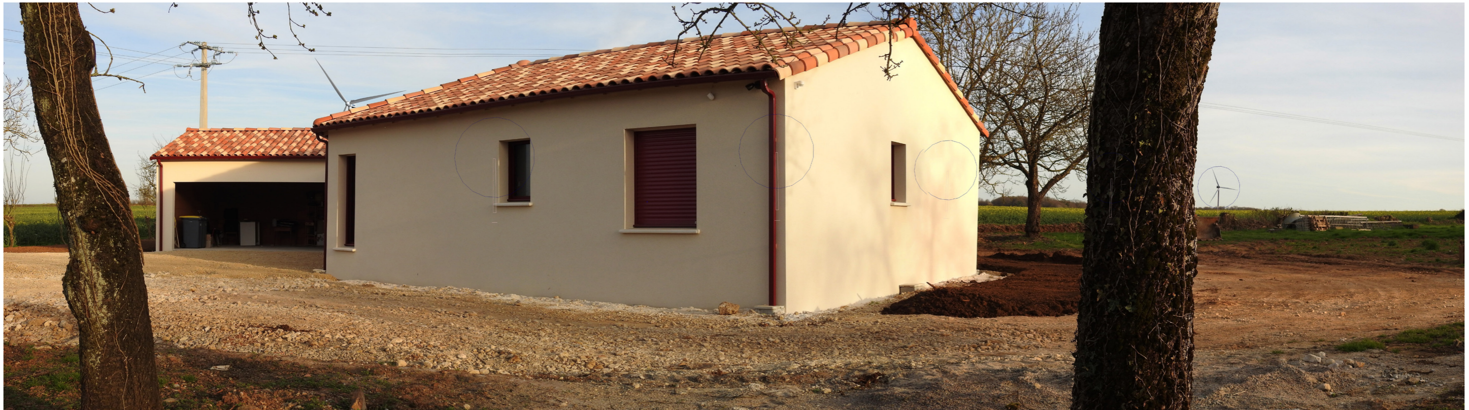
Au sud du bourg de Saint-Germier, une construction récente dispose d'une façade orientée vers le projet.
